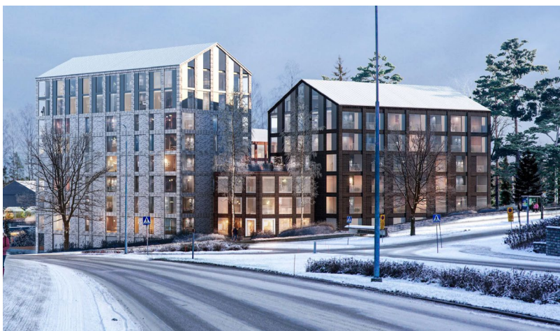
Kuva: Arco Oy 2025
